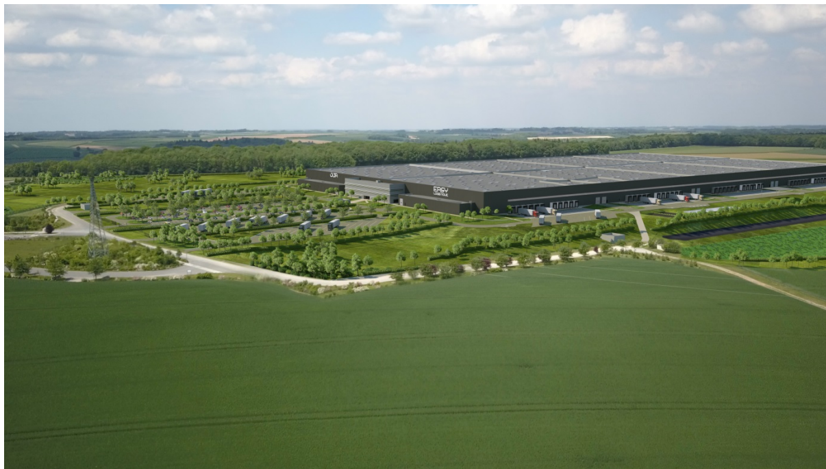
Figure 13 : vue aérienne sud-est/nord-ouest
